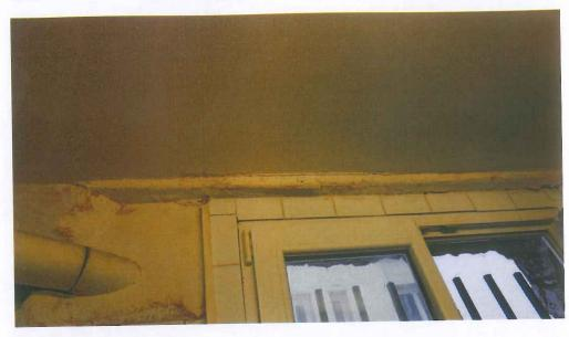
Cueillie de plafond mur de trumeau gauche : je constate des traces avec cernes de coulures jaunâtres, phénomènes de pulvérulence avec cristallisation.
